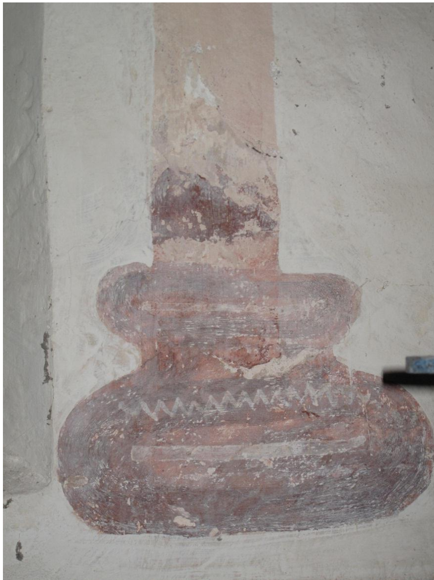
Fenstersäule NO. Befunde des Schaftes und der Basis
