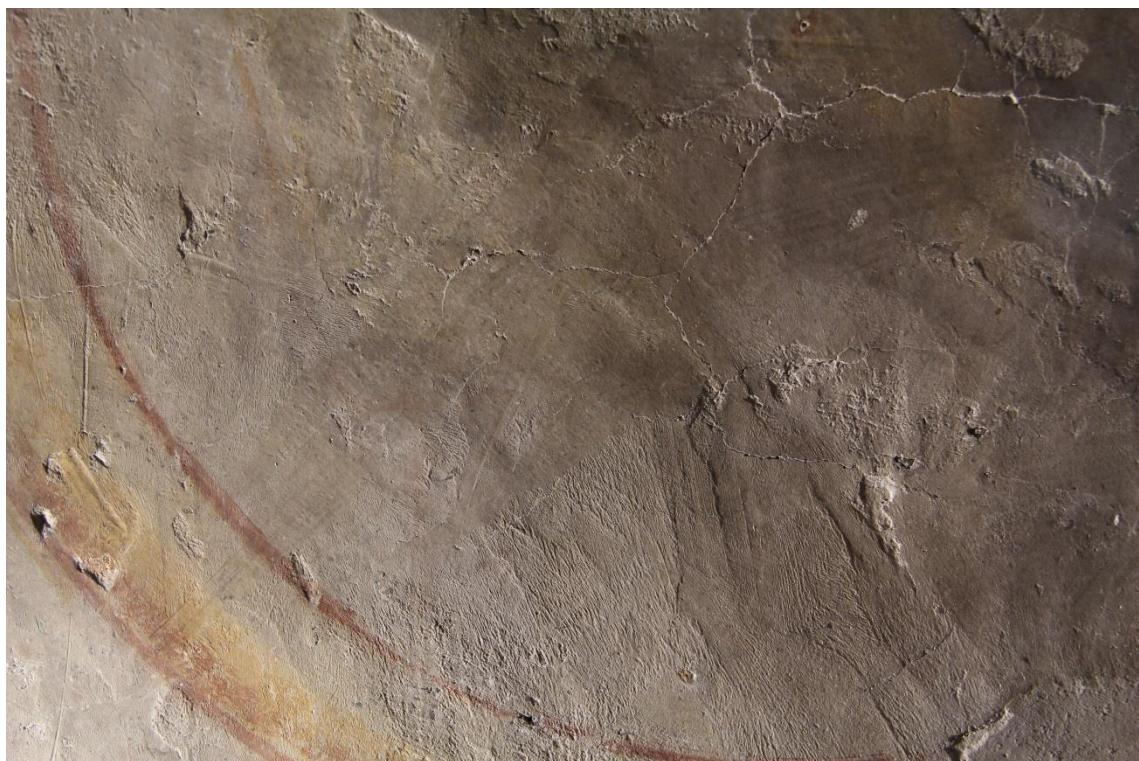
Glättungsspuren des Freskoputzes, Anreicherung von Kalksinterwasser beim Glättungsprozess an der Oberfläche (Ziehpuren). Nagelloch als Konstruktionshilfe.
