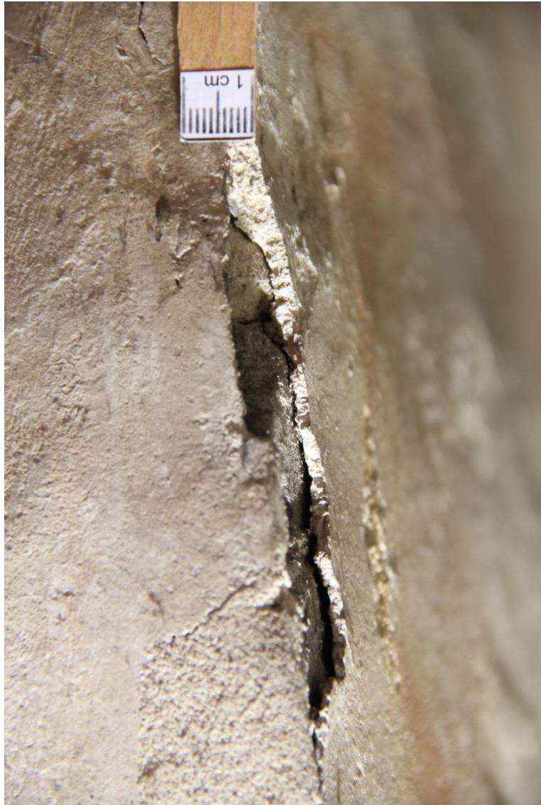
Der Putz ist hier nur 2-8mm dick und liegt ohne Unterputz direkt auf dem Bruchsteinmauerwerk.
