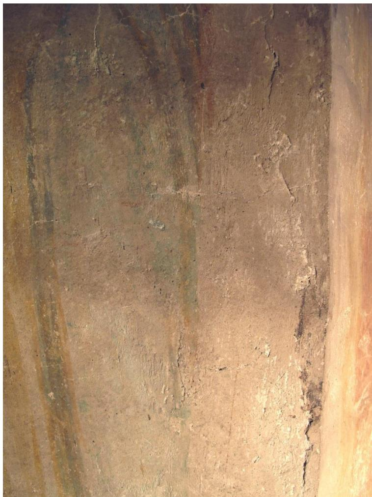
Putzgrenze auf der Wandfläche angrenzend zur Fensterlaibung. Die Putznaht ist dadurch entstanden, dass man die Putzportion beim Verputzen der Fensterlaibungen um die Ecke zur Wand gezogen und dann nass und nass sorgfältig die scharfe Putzkante geformt hat.
