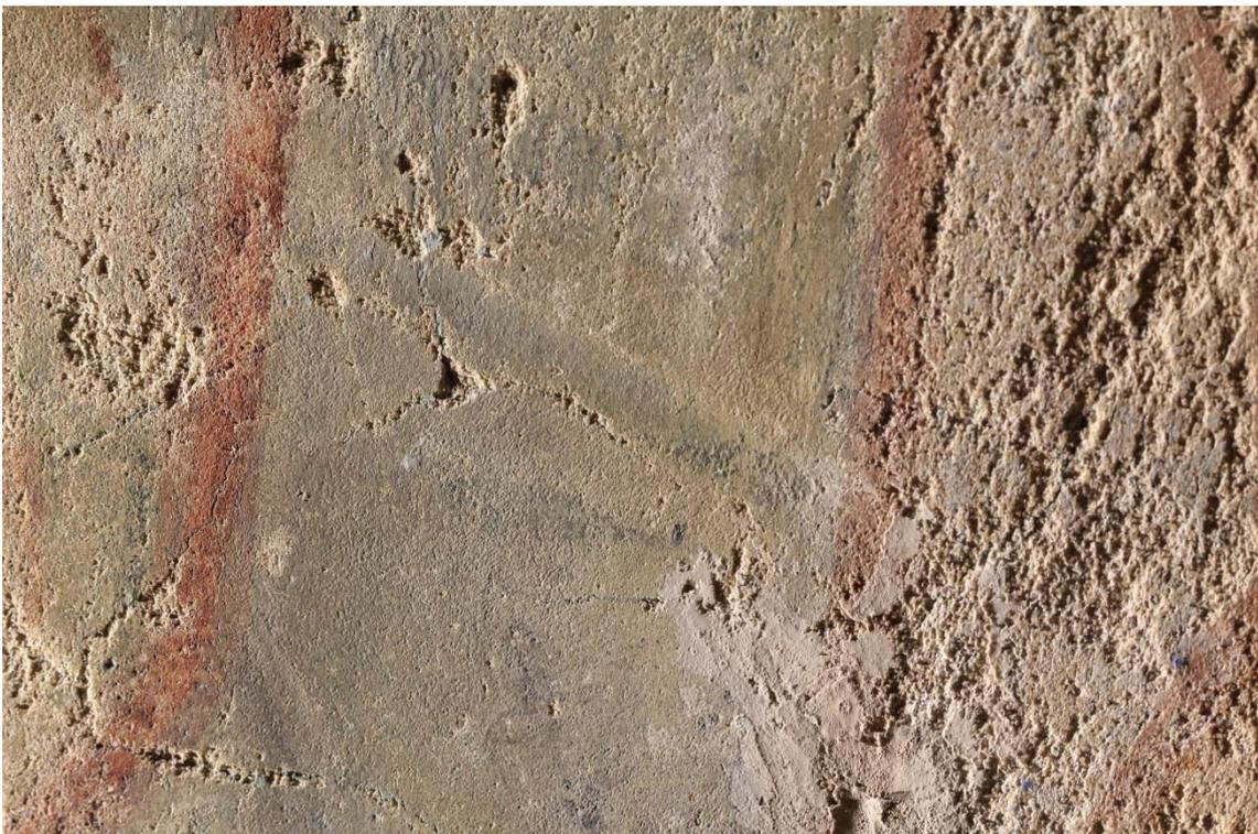
Glättungspur. Man kann erkennen, dass die Pigmente auf den frisch geglätteten Putz aufgetragen sind. Anreicherung von Sinterwasser beim Glättungsprozess auf der Oberfläche.
