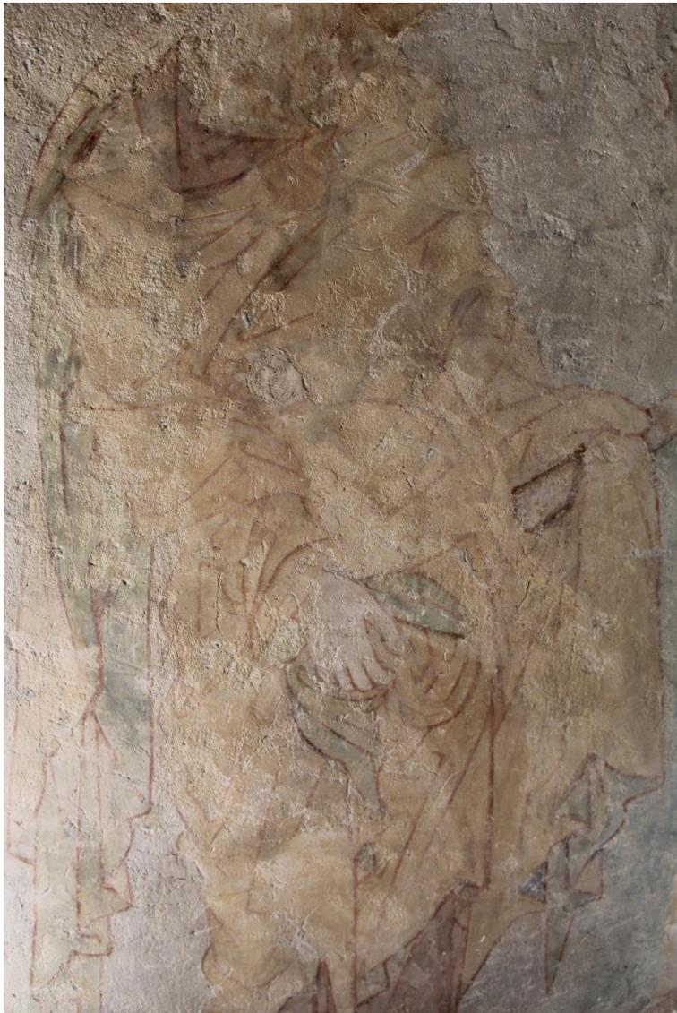
Vertikale Glättungsspur im gesamten Bereich des Gewandes mit der vollen Kellenlänge (12cm). Die Glättungsspur verläuft nahezu S-förmig. Im Bereich der Verdichtung des Putzes ist die Malschicht durch Austritt des Sinterwassers an die Putzoberfläche besser erhalten.
