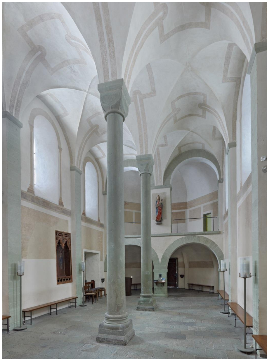
Blick auf den Westabschluss mit Empore und die zwei Schiffsäulen mit Würfelkapitellen.
