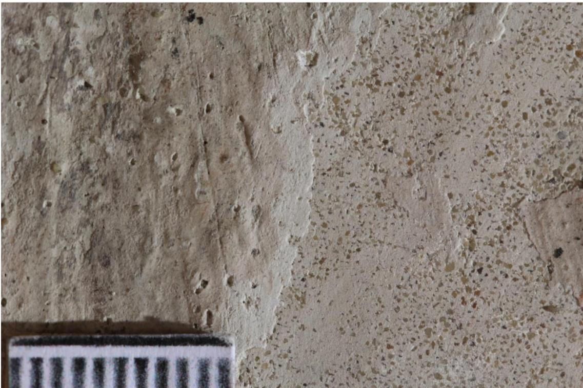
Der Putz besitzt überwiegend helle, feinkörnige Zuschläge und ist an der Oberfläche verdichtet, wodurch sich das Kalkbindemittel angereichert hat. Links daneben die aufliegende Kalktünche.
