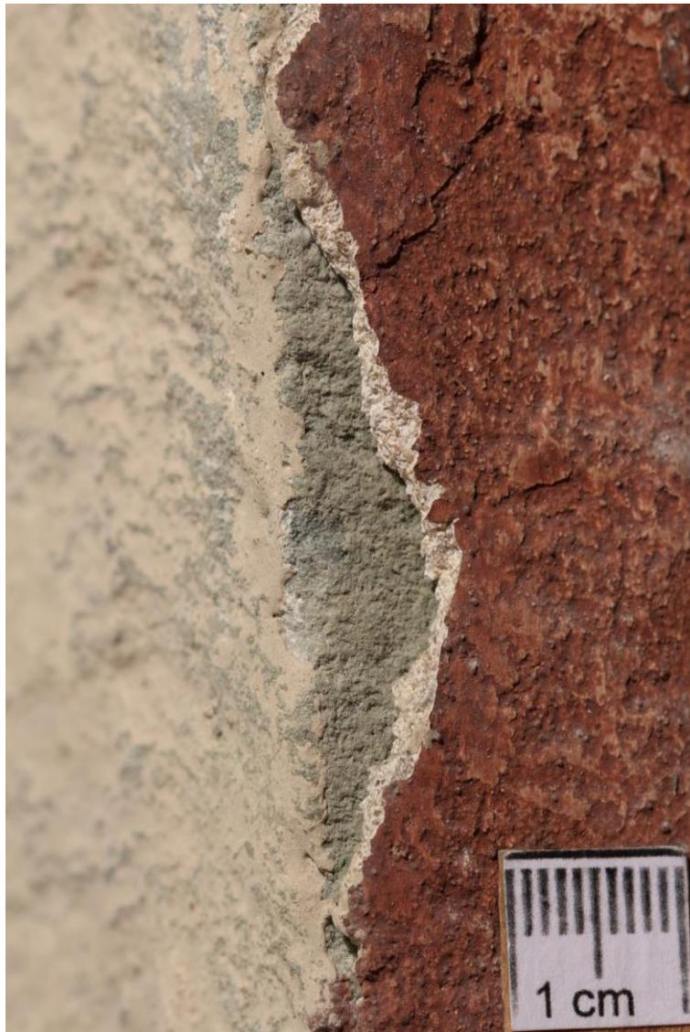
Der Putz läuft sehr dünn mit ca. 2 mm auf der Steinkante aus.
