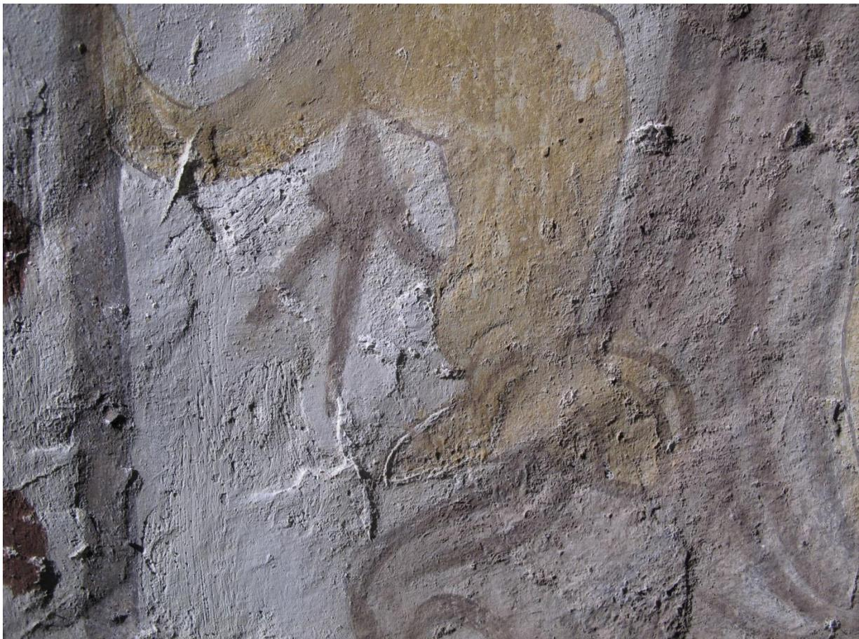
An der rechten Bärenpranke, die sich in das Gewand der Frau krallt, zeigt sich noch eine Ritzlinie im Putz an der hinteren Krallen. Dies ist ein Beleg für die Ausführung der Malerei im Baufortgang, als der Putz noch feucht war. Wenn zwischen dem Auftrag der Tünche als Malgrund und dem Auftrag des Putzes viel Zeit gelegen hätte, wäre eine solche Ritzung nicht mehr möglich ohne die Putzhaut stärker zu verletzen (weitere Ritzlinien siehe Kartierung Heiling).
