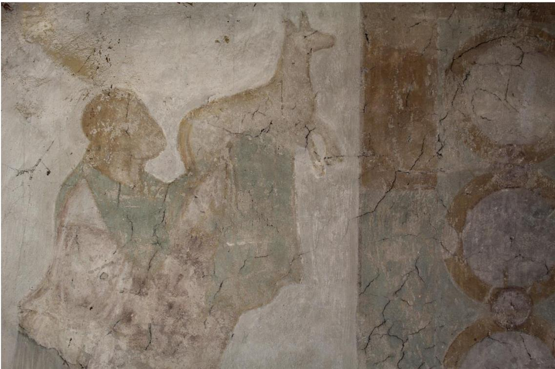
Bauzeitliche figürliche Malerei. Die Figur des Abels und der gemalte Wandteppich rechts weisen denselben Malschichtaufbau auf. Dieselben Farben (Grün, Ocker, Eisenoxidrot, Weißhöhlungen) wurden verwendet. Die Malerei der Figuren und des gemalten Wandteppichs gehört zusammen. Der kalkweiße Hintergrund ist neu überarbeitet. Die Malerei ist sehr verschmutzt.
