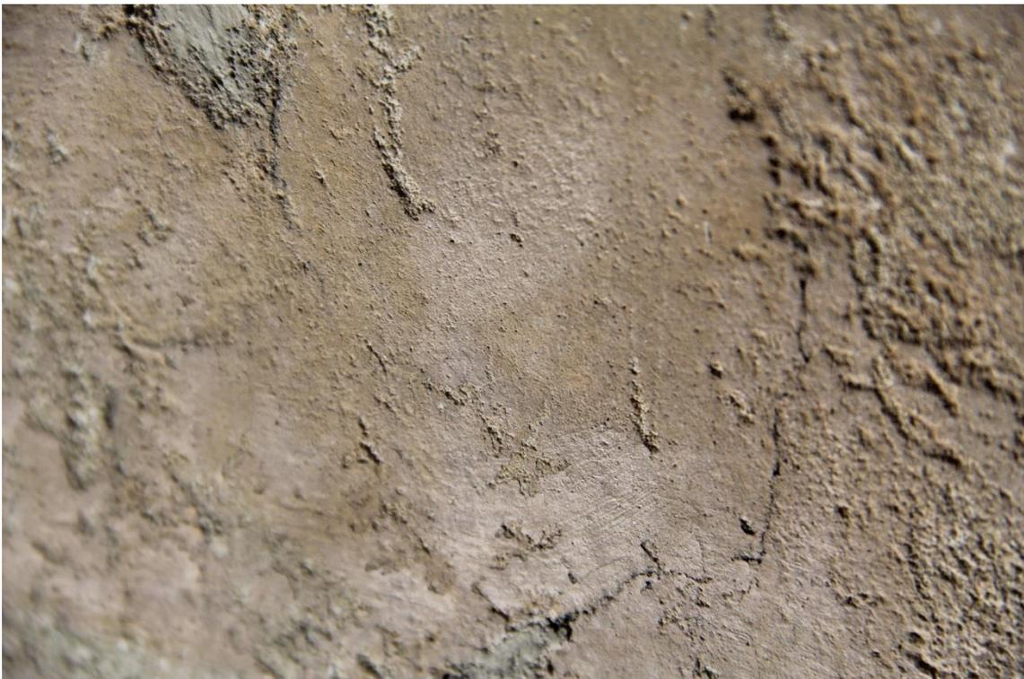
Makroaufnahme einer durch Glättung des feuchten Putzes entstandenen Sinterhaut auf der Malschicht. Es sind Ziehspuren der feuchten Kalkmilch zu erkennen, die sich durch die Glättung an der Oberfläche angereichert hat.
