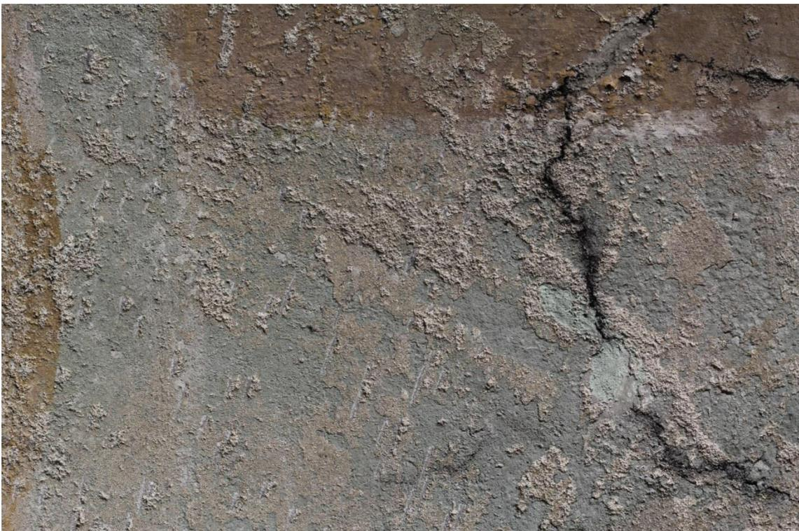
Eisenoxidrote Vorzeichnung der Rahmung. Auftrag der ockerfarbenen und grünen, unregelmäßig langen Quader. Die ockerfarbenen Quader wurden durchgehend eisenoxidrot unterlegt (vgl. Probe P09). Dort, wo die grüne Binnenfarbe des Quaders fehlt, ist der ockerfarbene Putzuntergrund zu sehen.
