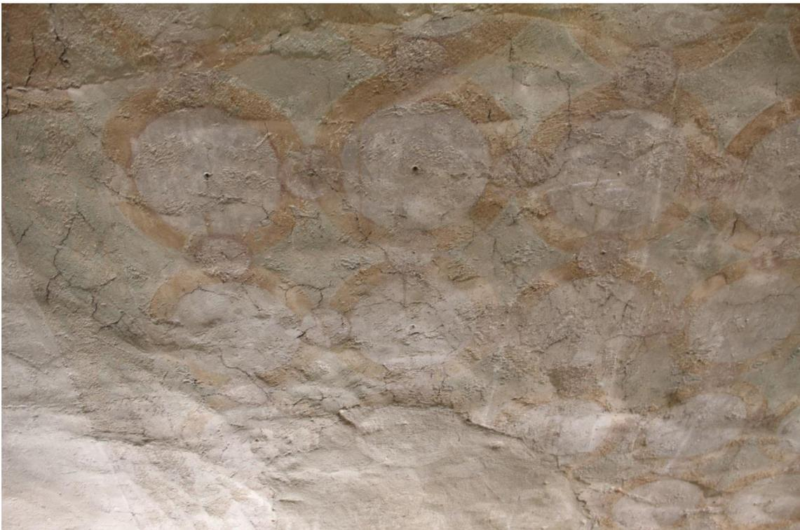
Glättungsspuren des Putzes. Raue Putzpartien wechseln sich mit geglätteten ab. Die Wandoberfläche ist leicht buckelig. Nagellöcher für die Kreisbögen sind zu erkennen.
