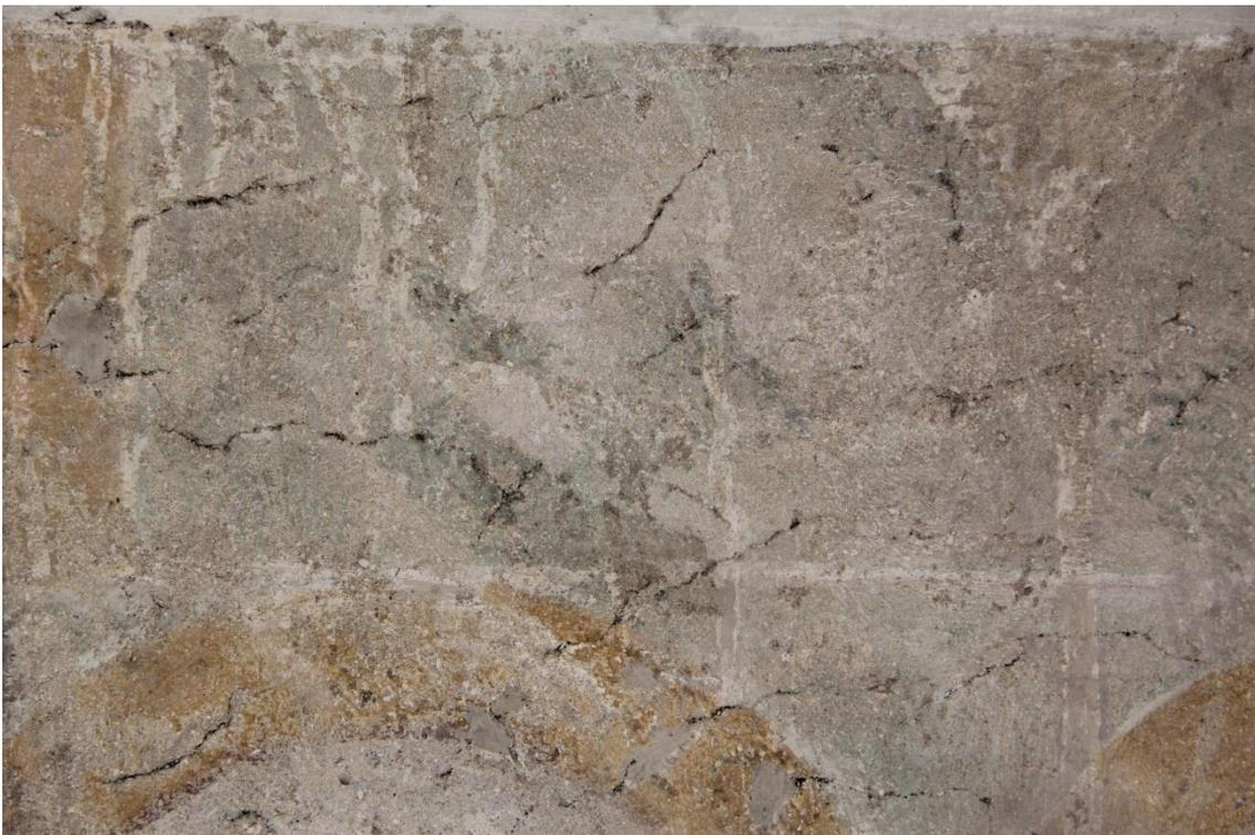
Wandteppich im Bereich der Reinigungsprobe, gereinigter Zustand. Es sind Kalkläufer, vom gekalkten Hintergrund ausgehend mit originaler Malschicht zu erkennen. Das deutet darauf hin, dass erst der Hintergrund gekalkt und danach die Figuren und der Wandteppich, noch in den frischen Putz, gemalt worden sind.
